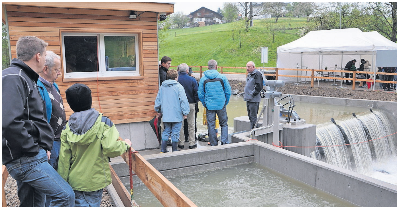
Fasziniert verfolgten die Besucher, was beim Einlaufbecken des Kleinwasserkraftwerkes Dreien geschieht.
