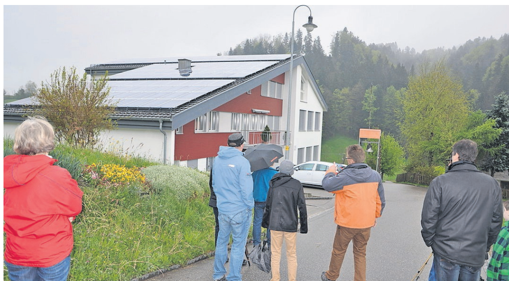
Bei der Photovoltaikanlage auf dem Schulhausdach von Dreien gab es nicht sehr viel zu sehen.
